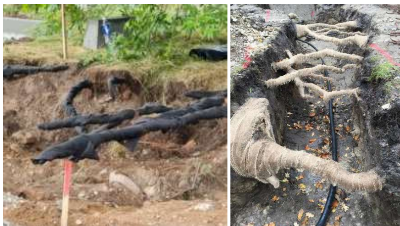
Pav. 7. Šaknų apgaubimas geotekstile, vykdant darbus.
